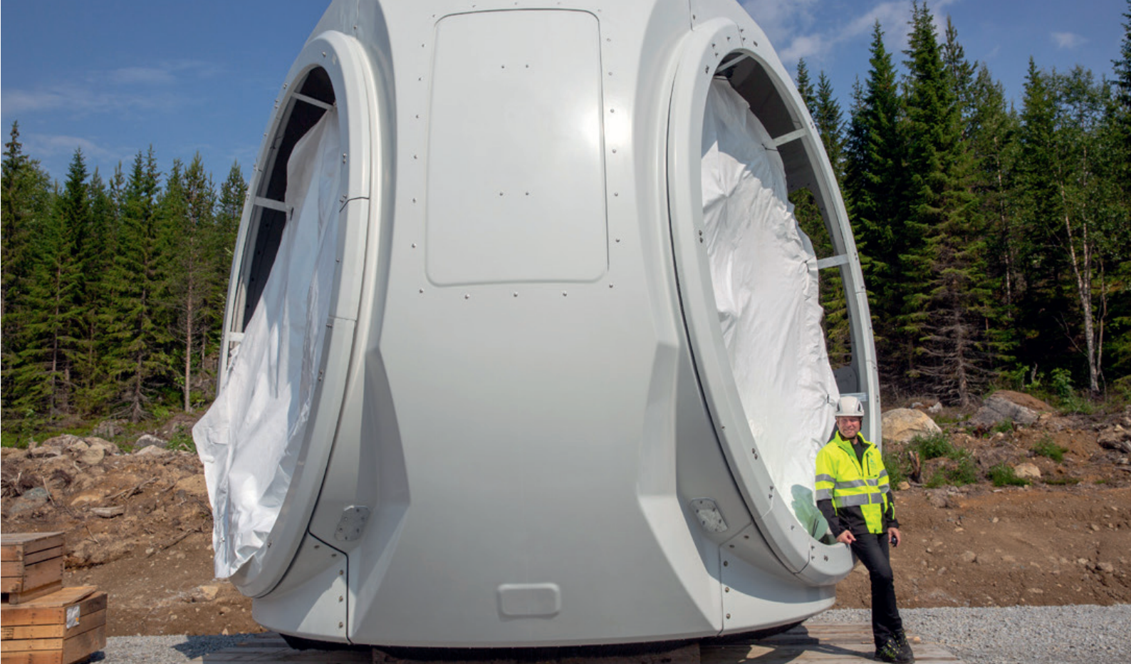
Gabriel Duveskog, vd för Hocksjön Vind, vid bygget av den nya vindkraftparken.
