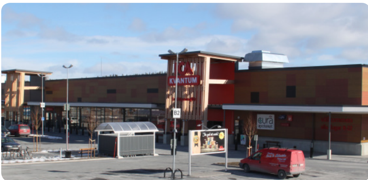
Köpcentrat på kvarteret Släpvagnen i Östersund är en fortsättning på den miljöatsning som Persson Invest under många år gjort på sina fastigheter. Fastigheten är självförsörjande på värme genom en väl isolerad byggnad, värmeåtervinning av kyl/frysanläggningar och bergvärme. Fastigheten skall Green Building certifieras, vilket innebär en energiförbrukning som är minst 25% lägre än byggnormen.
